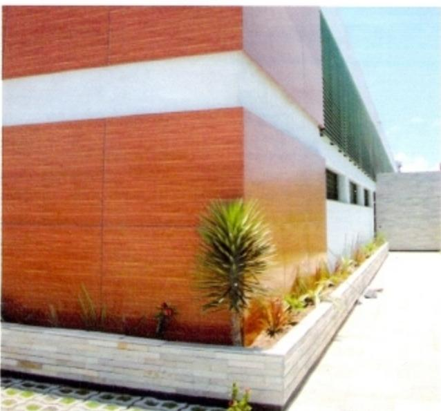
A fachada foi revestida de alumínio composto pintado: as chapas de Tecbond (Day Brasil) medem 1,25 x 3 m, recebem proteção contra ferrugem e podem ser instaladas sobre qualquer superfície em paredes internas e externas. Day Brasil, R\$ 47,74 o m<sup>2</sup> (a colocação custa cerca de R\$ 35 o m<sup>2</sup>).
